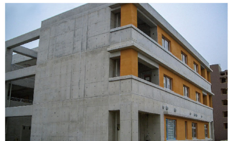
コンクリート壁
