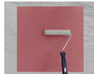
ローラー均し
